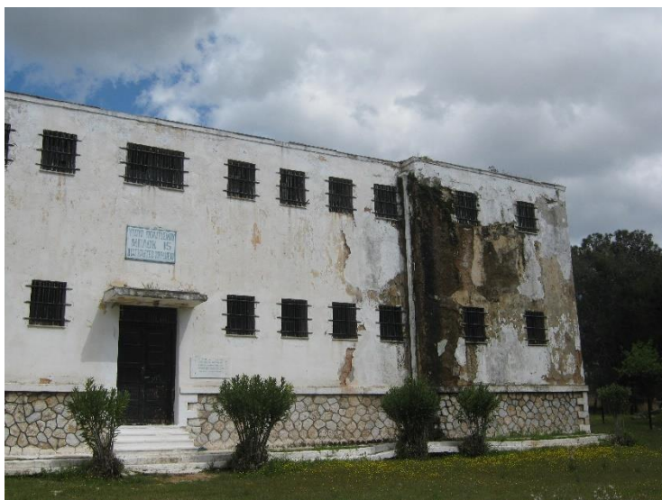
Μπλοκ 15, στρατόπεδο Χαϊδαρίου, 2015, οι δυο όψεις του κτηρίου (φωτογραφίες από προσωπικό αρχείο Μαρίας Φραγκουλάκη). Δεξιά της εισόδου αναθηματική πλάκα. Τόπος μνήμης ηρώων και μαρτύρων εθνικής αντίστασης 1943-44.
